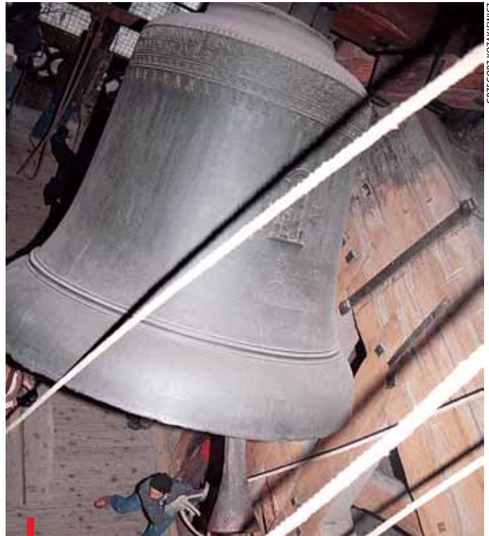
Gdy „Zygmunt” dzwoni, obciąża konstrukcję, na której wisi, siłą ok. 30 ton
