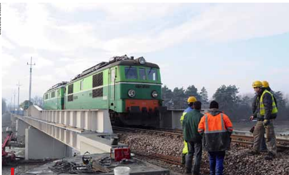
STARY SĄCZ. 12 stycznia odbyły się próby obciążeniowe. Most ma nośność 2 tys. ton
