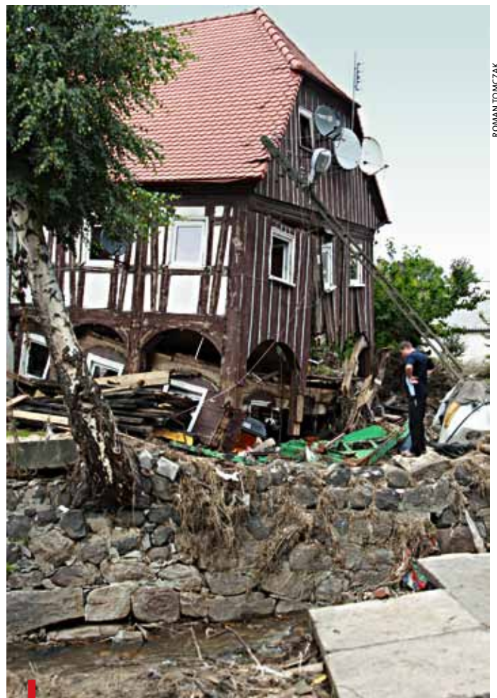
Powódź w Bogatyni zniszczyła wiele zabytkowych domów przysługowych. Władze chcą wyburzenia prawie połowy z nich. Przeciwni są mieszkańcy i organizacje społeczne
