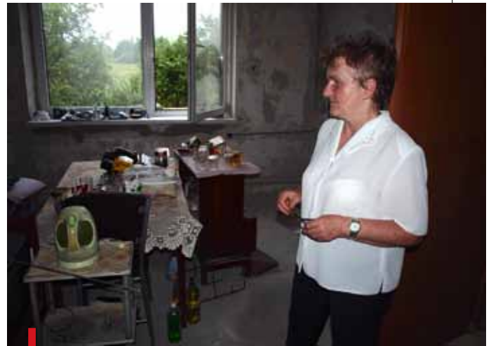
– Wśród tych remontów i wilgoci trudno wytrzymać – mówi Danuta Friedrich z Kaniówka
