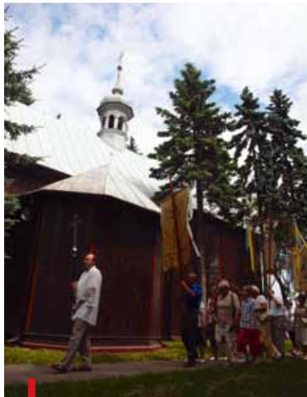
Kościół konsekrowany w 1598 roku był wielokrotnie remontowany i przebudowywany
