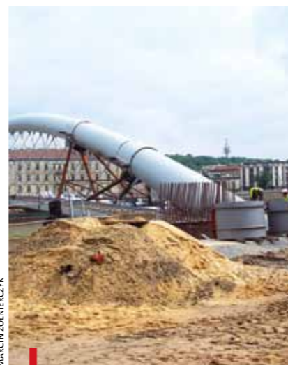
Mocowanie kładki na przyczółkach i budowa balustrad będzie trwać do września
