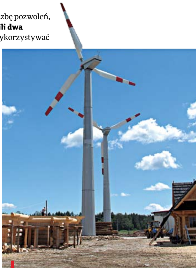
Energia z dwóch wiatraków będzie wykorzystywana na potrzeby firmy budującej domy. Nadwyżka zostanie sprzedana do elektrowni
