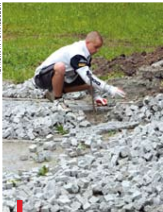
Układanie granitowej kostki brukowej dobiega końca
