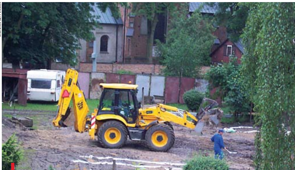
CIECHANÓW. Przed kościołem farnym trwają przygotowania terenu pod budowę pomnika-ołtarza
