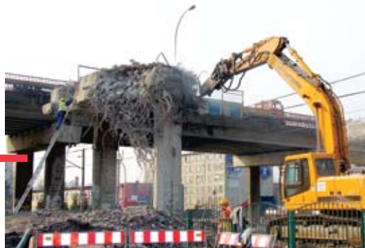
Przebudowa wiaduktu pochłonie 35 mln złotych
