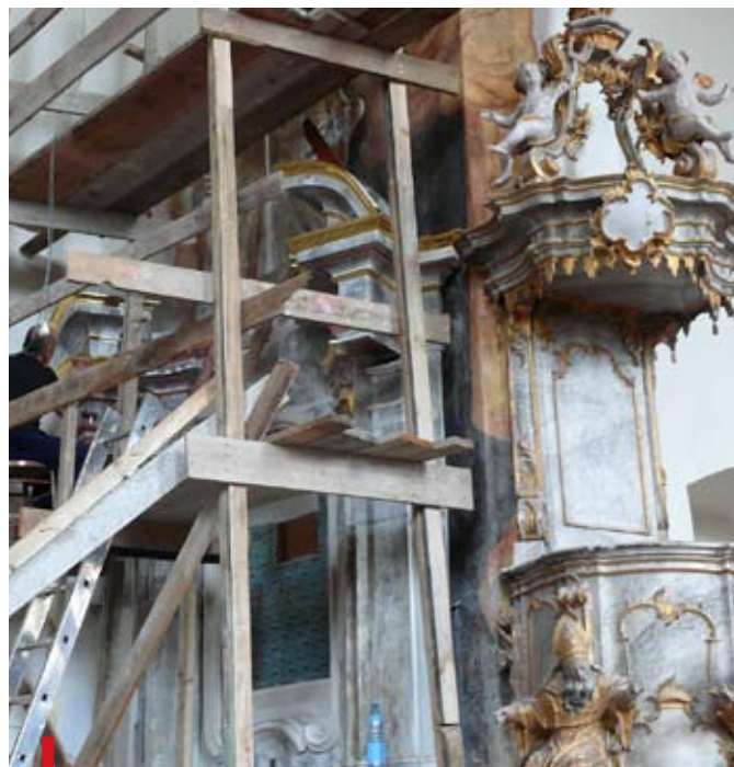
Trwają prace konserwatorskie przy ołtarzu bocznym Matki Bożej Różańcowej
