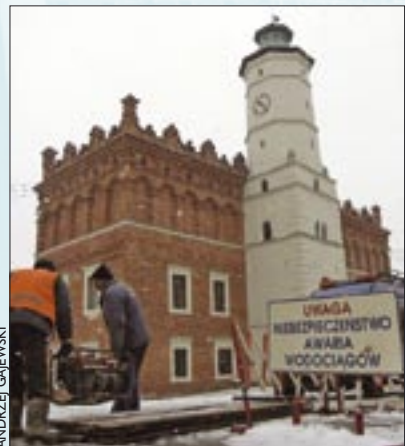
Grudniowa awaria sieci wodociągowej na sandomierskiej Starówce
