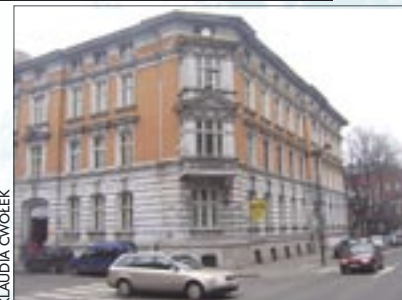
Siedziba Urzędu Statystycznego w Gliwicach
