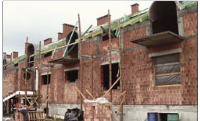
Kolejny budowany pawilon. Znajdą się w nim kuchnia, jadalnia, pralnia, magazyny i zaplecze
