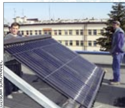
Montaż rur tworzących kolektor słoneczny
