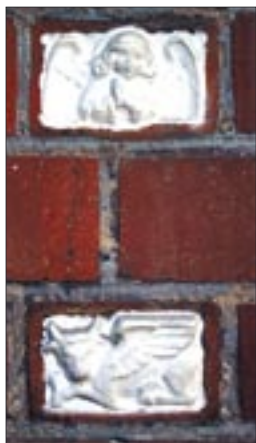
Piękno murarskich detali sprzed 100 lat jest zdumiewające
