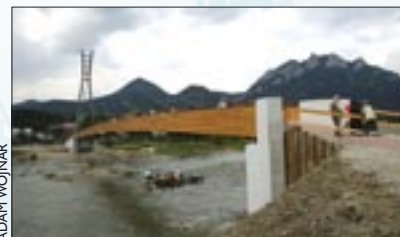
Od inspektora nadzoru budowlanego zależy, jak długo kładka pozostanie zamknięta
