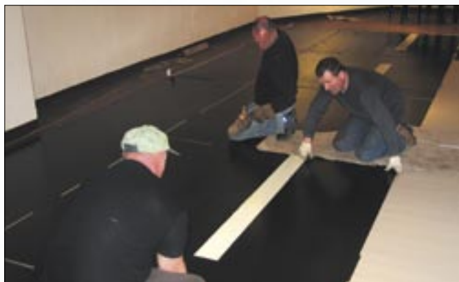
Przygotowania do instalacji trwały kilka dni
