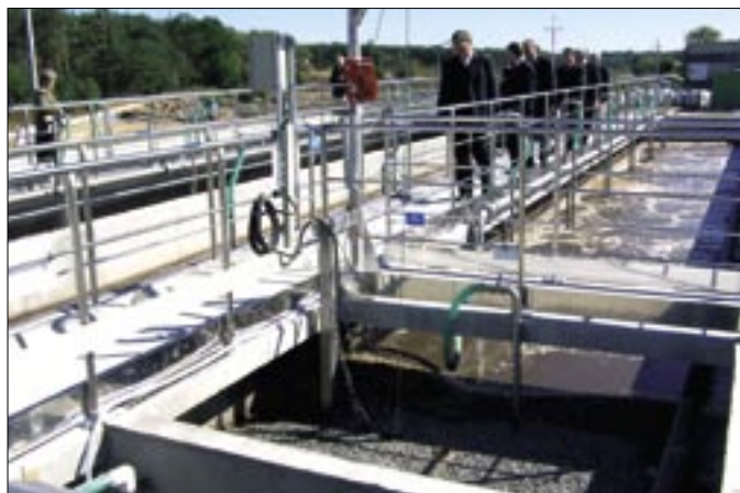
OŻARÓW. Nowoczesna oczyszczalnia ścieków dla gminy istotnie przyczyni się do poprawy stanu ochrony środowiska.
